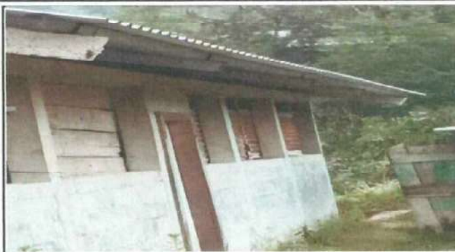
Foto 2: paredes del centro educativo donde se puede verificar la necesidad de repellar las paredes, ya que hace tiempo no se ha dado mantenimiento por falta de recurso economico
