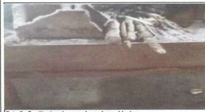
Foto 5: Sustitucion de poyo de madera a blocks
